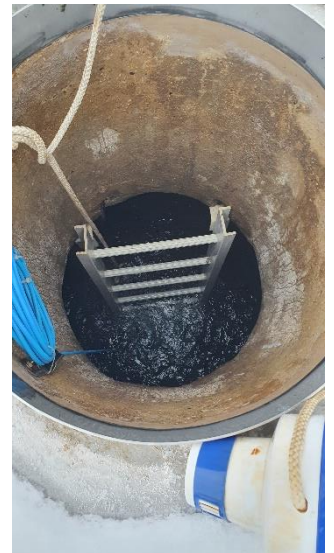
Figure 1 : Aperçu du sommet du réservoir
