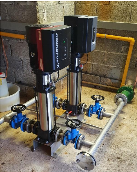
Figure 4 : Surpresseurs GRUNDFOS
