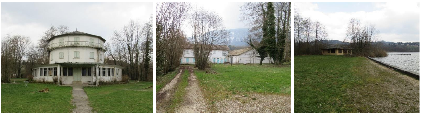
Hôtel rond, bâtiment « annexe » et bâtiment « chasse »
