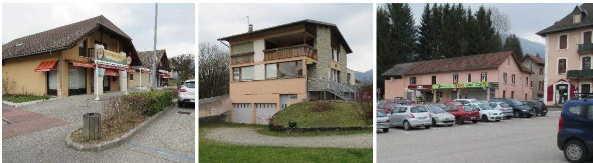
Photographies 2 – Boulangerie et boucherie ; bâtiment accueillant l'agence postale communale et le projet de nouvelle mairie ; coiffeur, bar-tabac-pressé et supérette (Eco-Stratégie 21/03/2018)
